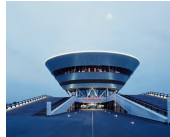
Porsche-Werk Leipzig: Kundenzentrum / Porsche plant Leipzig: Customer Centre by gmp
