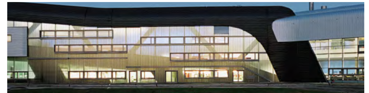
BMW-Werk Leipzig: Empfangsgebäude / BMW plant Leipzig: Central Building by Zaha Hadid
