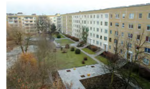
Bestand vor Sanierung / The same blocks before energy-efficient upgrading
