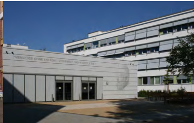
Wilhelm-Ostwald-Gymnasium: Schulhaussanierung / refurbished secondary school
