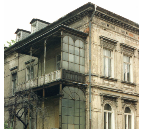
Unsanierter Bestand in der Christianstr. - 1994 (C. Eisler / Stadt Leipzig)
