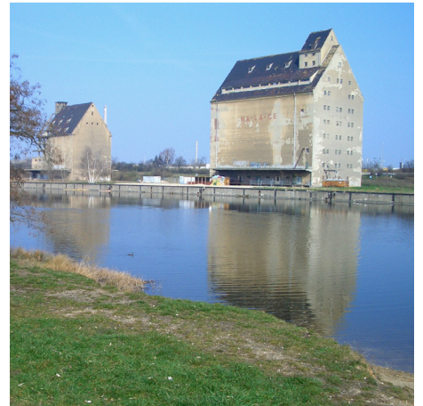
Speichergebäude am Lindenauer Hafen (Stadt Leipzig)
