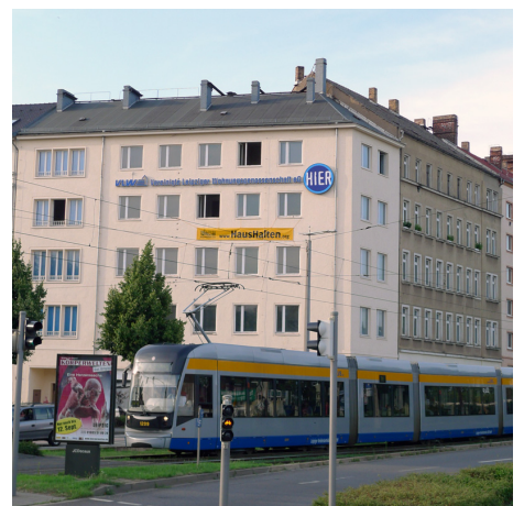
Wächterhaus in der Delitzscher Straße - Nachkriegsbau (Stadt Leipzig)
