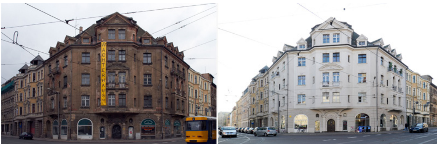
Wächterhaus in der Demmeringstraße - vorher und nachher (Stadt Leipzig)
